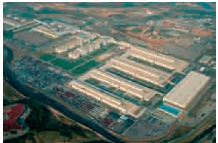
B. Zone industrielle dans la banlieue de Rennes © Hoa Qui
